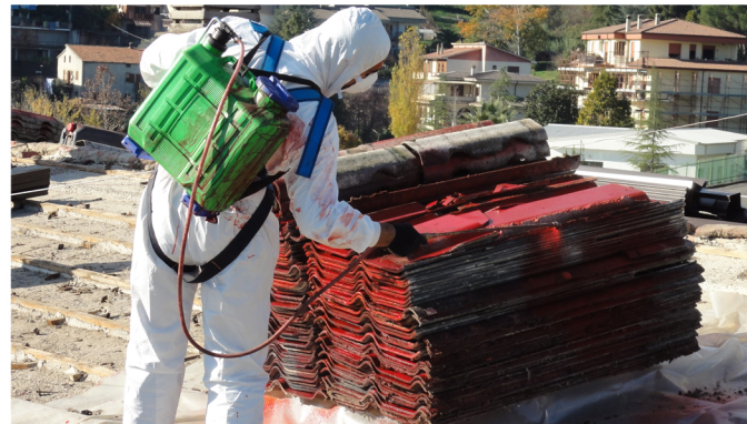
rimozione di lastre di copertura
