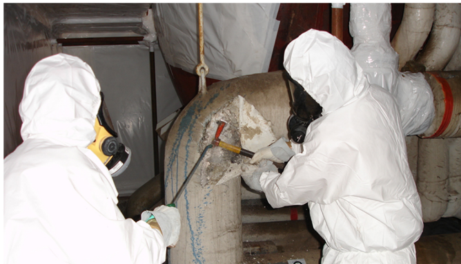
scoibentazione di tubazioni
