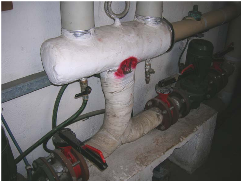
Immagine n°5 - Coppella in MAC friabile su tubazione di una centrale termica (da letteratura di settore)
