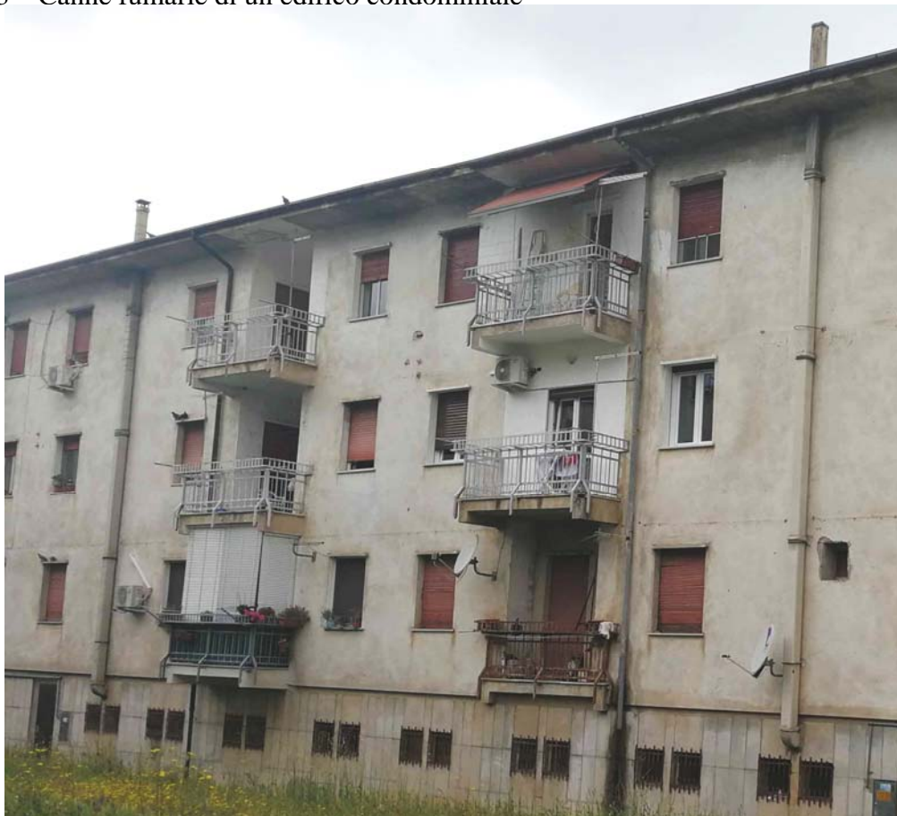
Foto n°3 – Canne fumarie di un edificio condominiale
