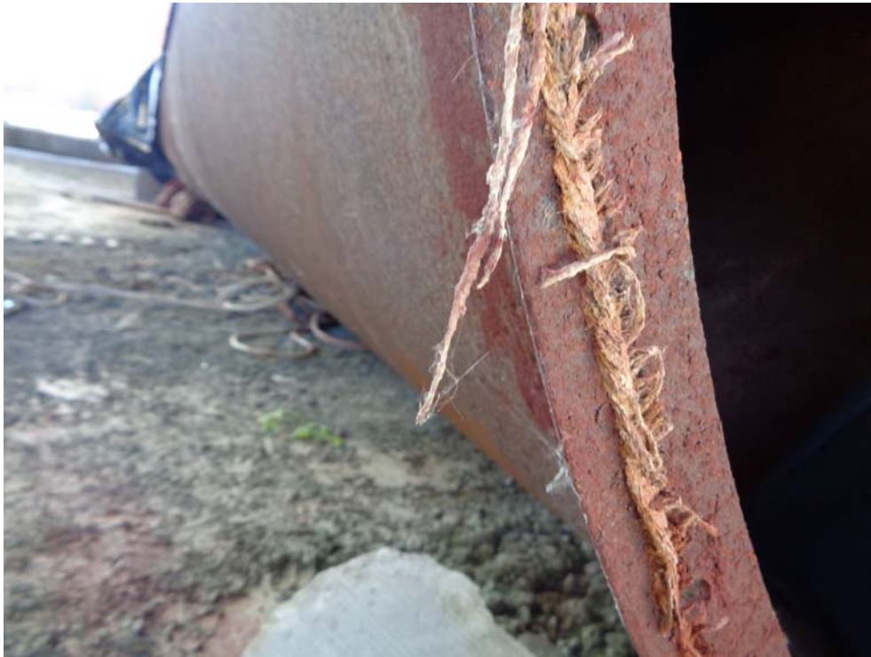
Foto n°6 – Guarnizione in tessuto di crisotilo (giunto condotta di ventilazione) (fonte: foto effettuata dal sottoscritto nel corso della direzione dei lavori di bonifica dell'ex fabbrica laterizi FIL di S. Caterina Albanese – Cs)
