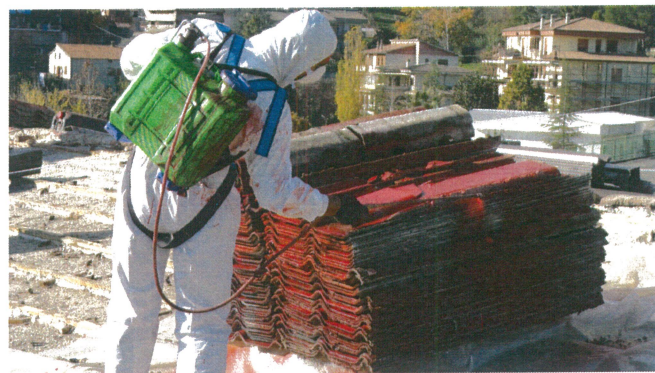
rimozione di lastre di copertura
