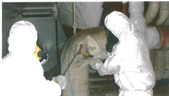
scoibentazione di tubazioni
